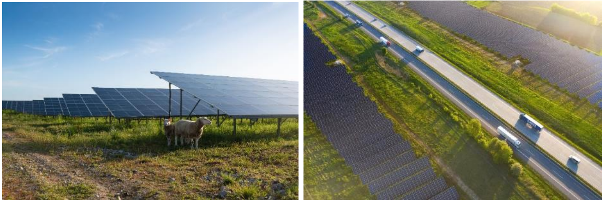
Abbildung 4: Beispiele für Module einer Freiflächen-PVA desselben Vorhabenträgers in Schönbek (Autobahndreieck Bordesholm) (Quelle: Enerparc AG, Hamburg)
